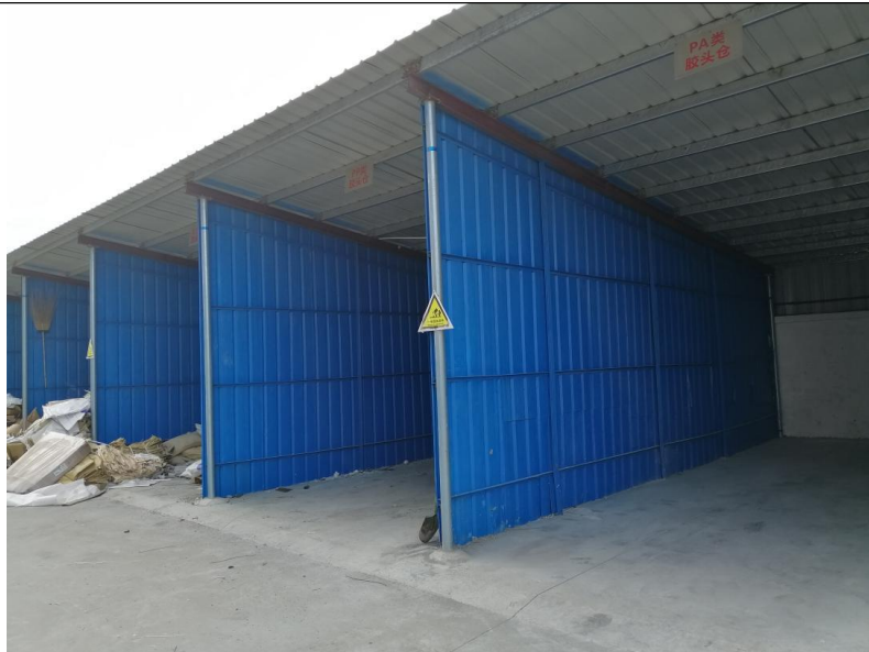
工业固体废物仓库-1
