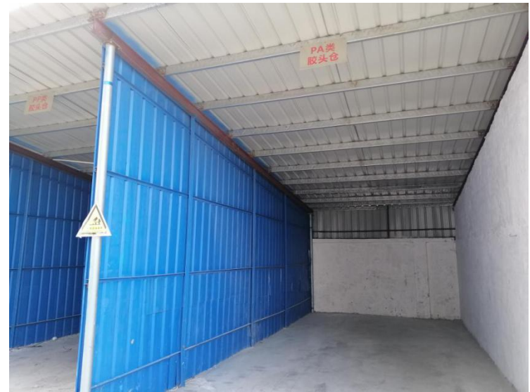
工业固体废物仓库-2
