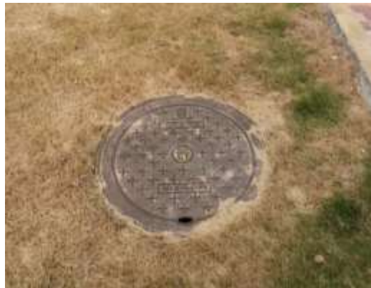
生活污水排放口
